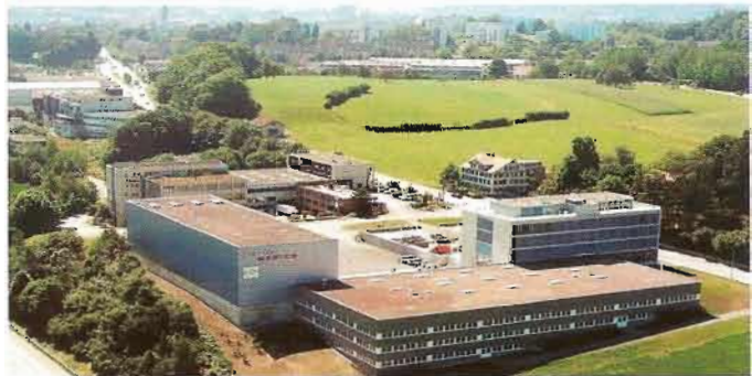
Büro- und Logistikcenter: heizen und kühlen
